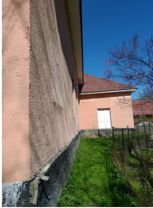
Fig. 3. Latura nord-estică a construcției studiate
