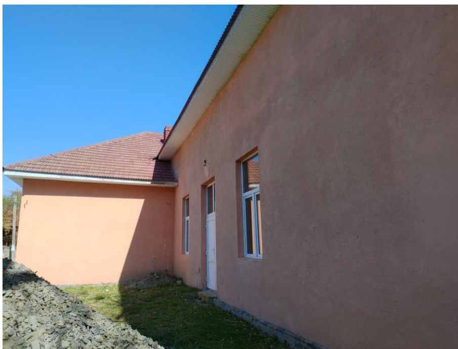
Fig. 2. Latura sud-vestică a construcției studiate
