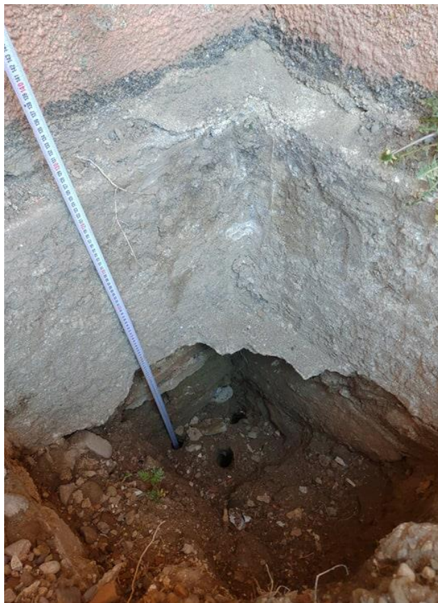
Fig. 7. Sondajul S1, cu dezvelirea fundației clădirii pe latura sud-vestică
