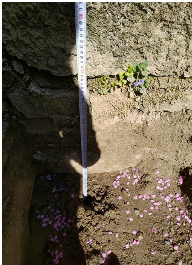
Fig. 8. Sondajul S2, cu dezvelirea fundației clădirii pe latura nord-estică
