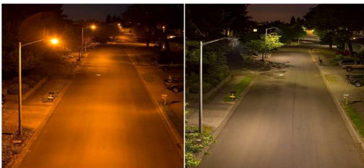
Fig. 1.2. Comparație între sistem de iluminat cu vapori de sodiu de înaltă presiune și sistem de iluminat cu LED
