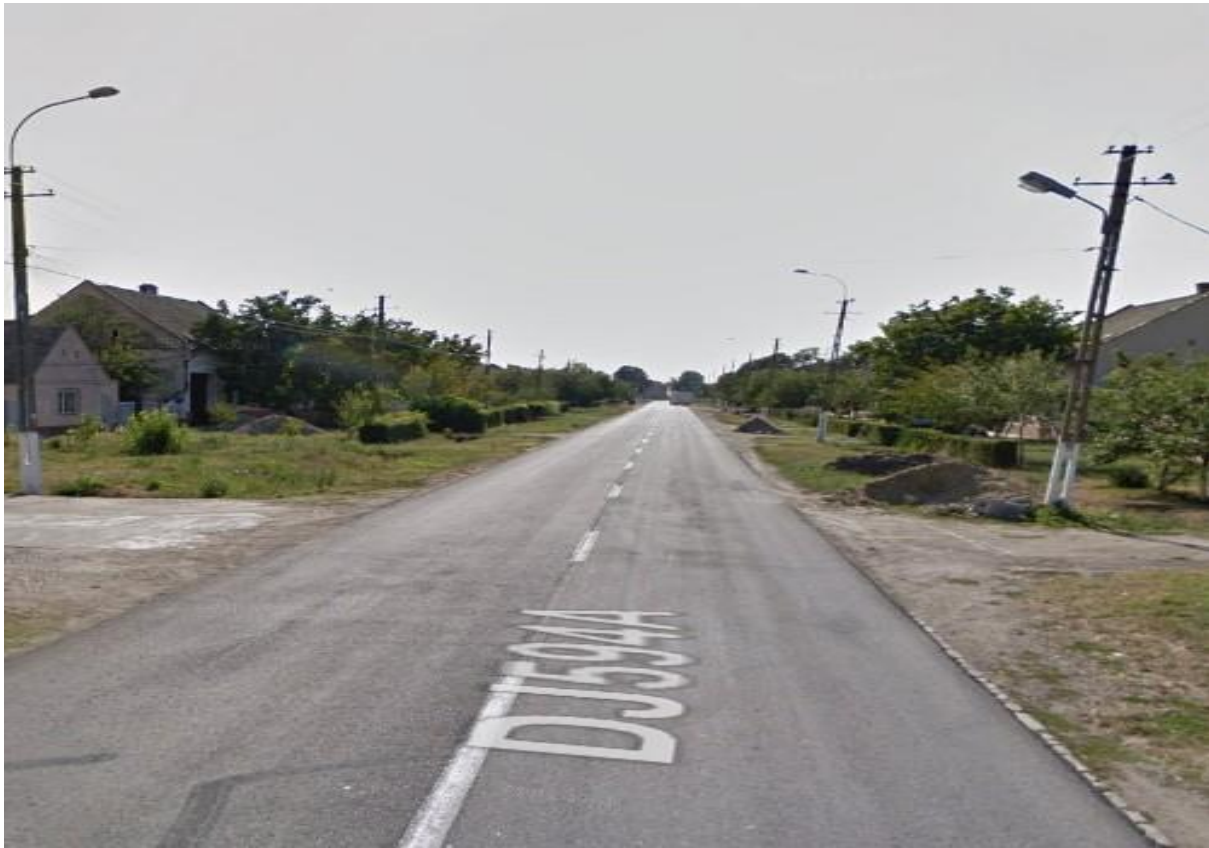
Iluminat bilateral lampi sodiu cu dispersorul mat
