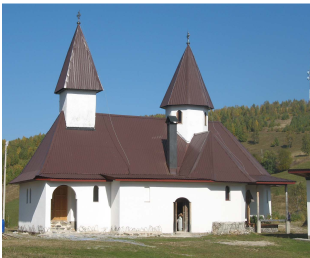
Fig. 11 Mănăstirea Muntele Rece
